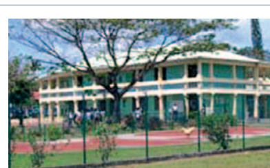
L'école Massabielle, à Baie-Mahault.
